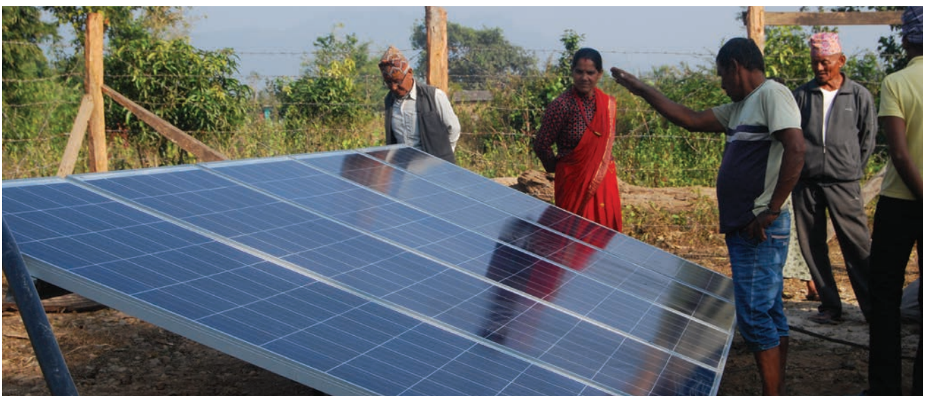
Gambar 15: Instalasi sistem irigasi tenaga surya di Nepal untuk mengumpulkan air dari sungai ke kolam yang akan digunakan untuk irigasi selama musim kemarau. Kredit foto: Shobha Manandhar
